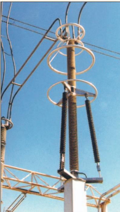
Fig. 3. Pararrayos con carcasa de polímero resistente a terremotos.
