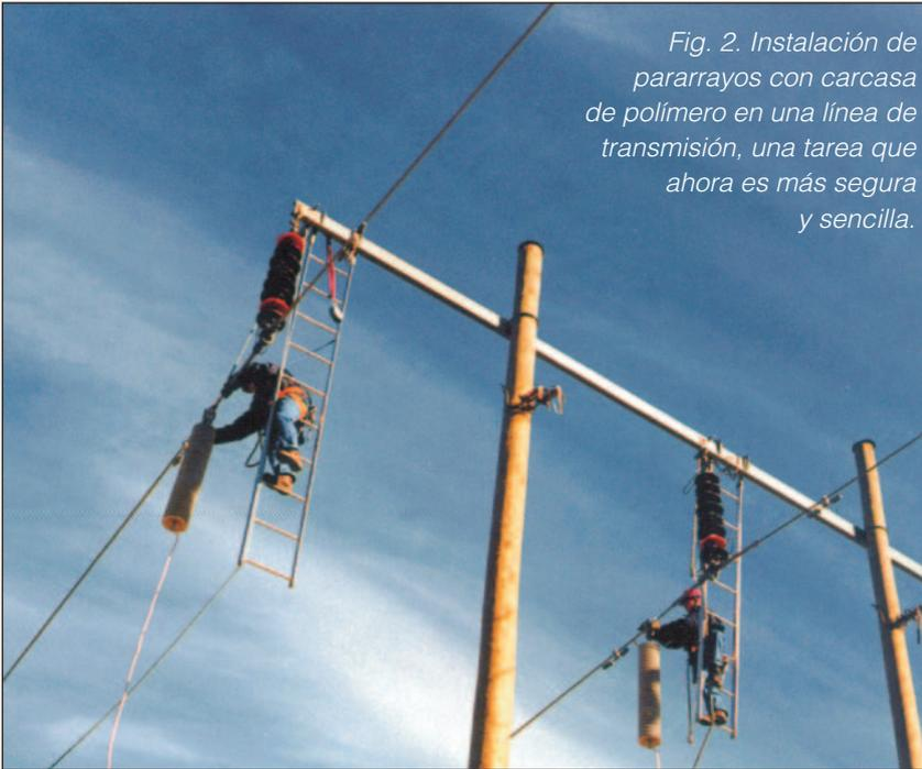
Fig. 2. Instalación de pararrayos con carcasa de polímero en una línea de transmisión, una tarea que ahora es más segura y sencilla.
