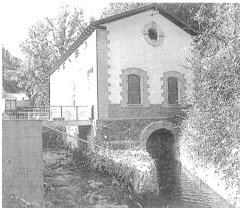
Rehabilitación de la central hidroeléctrica de Vozmediano (Soria) en el río Queiles (320 kW) (Fuente: ERZ)
