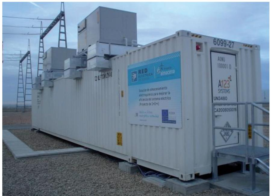
Grupo containerizado de baterías ión-Li de la subestación de REE
