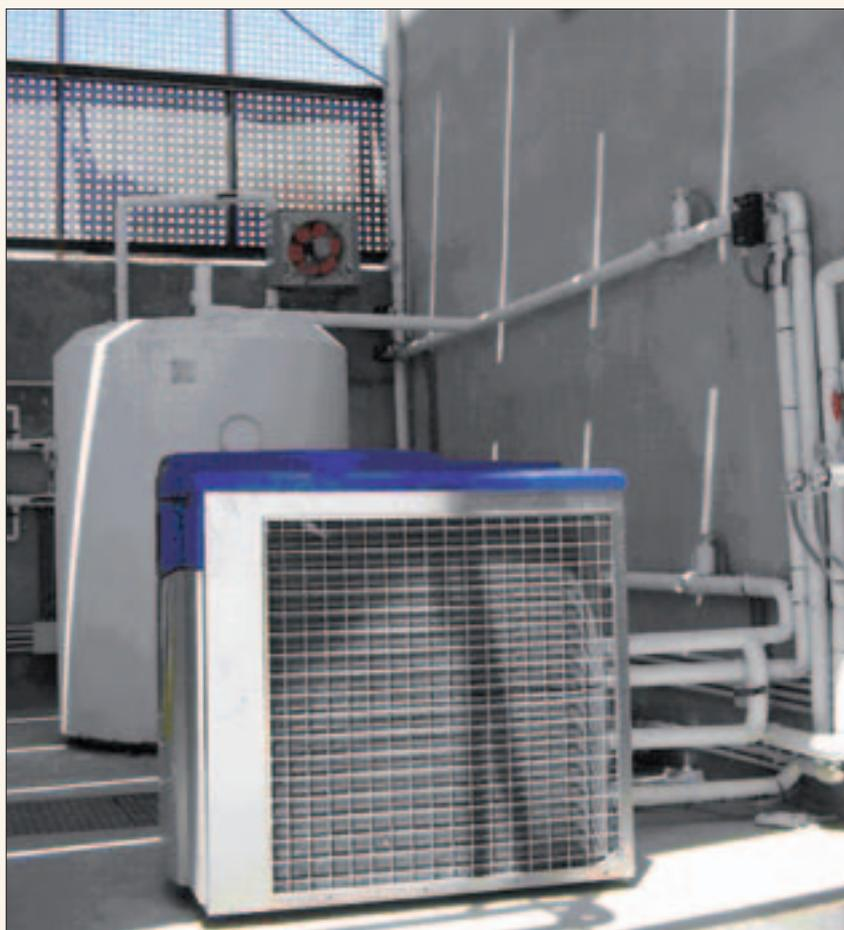
Vista general de la instalación: acumulador, circuitos hidráulicos y máquina de absorción ejecutada por **PJS, Proyectos e Instalaciones**.
