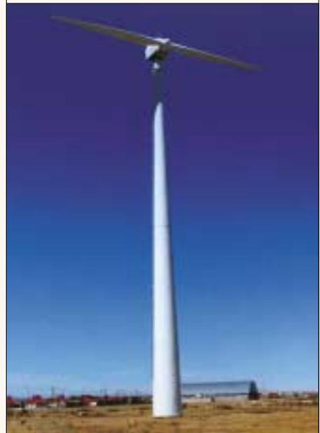
*Turbina bipala de 150 kVA conectada a una red de distribución de media tensión. Pico Truncado (Argentina)*
