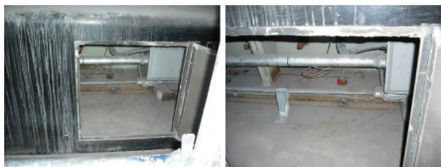
Figura 14: a) Localización de fuga en conducto termopar b) fuga reparada
