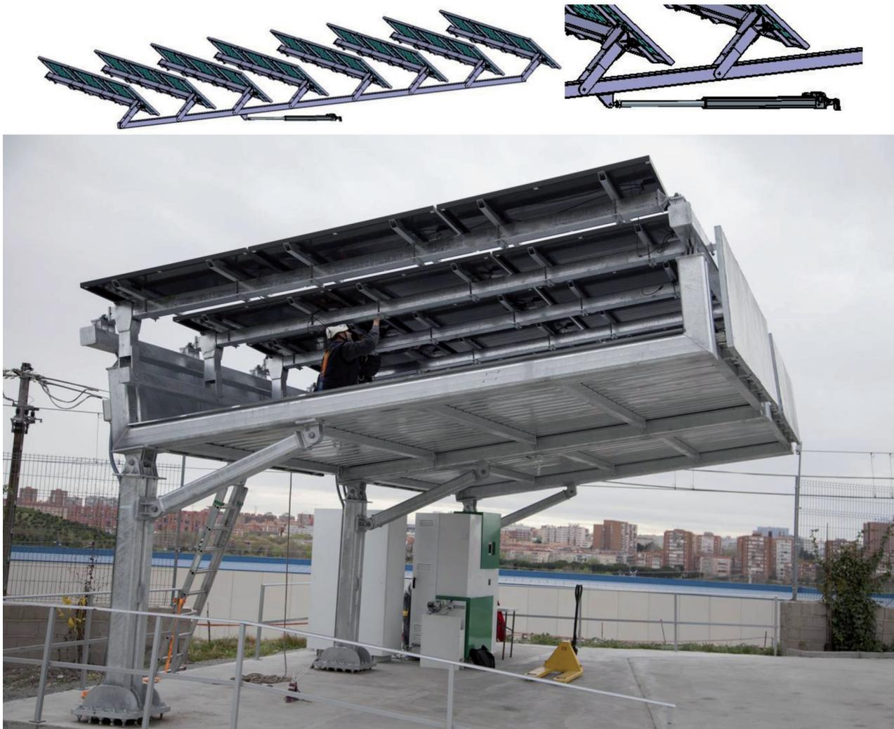
Figura 7: Estructura metálica y mecanismo de seguimiento instalado en cubierta
