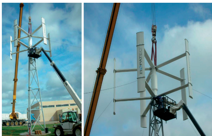
Fig. 5: Torre y turbina fotos de montaje
