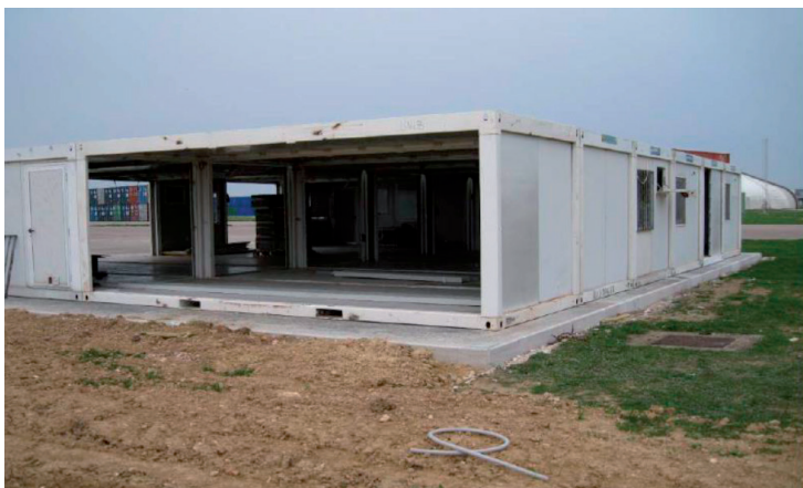
Fig. 4: Vista del edificio prefabricado montado
