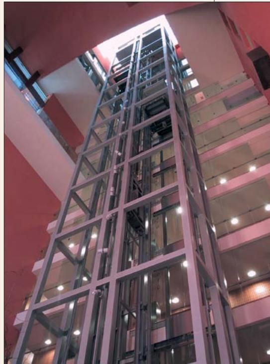
Figura 2. Ejemplos de realizaciones en acero: Estructura de acero para los ascensores del atrio del Hotel Sheraton, en Bilbao. Foto por cortesía de Aurtenechea & Pérez-Iriondo Arquitectos (izquierda) y Estructura metálica del nuevo edificio del Gobierno Vasco en Bilbao (derecha)
