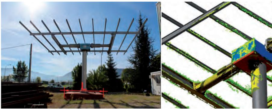
Fig. 6a: Fotografía de la estructura del panel solar. Fig. 6b: Modelado 3D a partir de la nube de puntos
