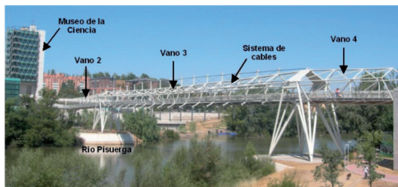
Fig. 3: Vista general de la PMC de Valladolid
