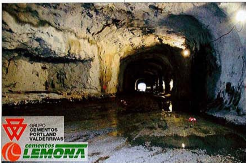
Foto de la galería principal en la cota 195 m
