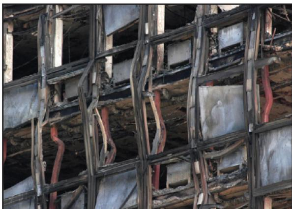
Figura 5: Pilares inferiores deformados por la agresión térmica frente a los pilares superiores intactos al estar protegidos frente al fuego
