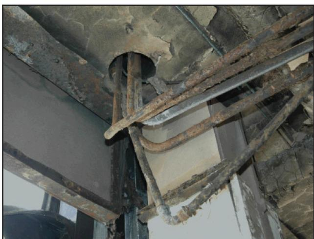
Figura 7: Paso de instalaciones por forjado sin sellado
