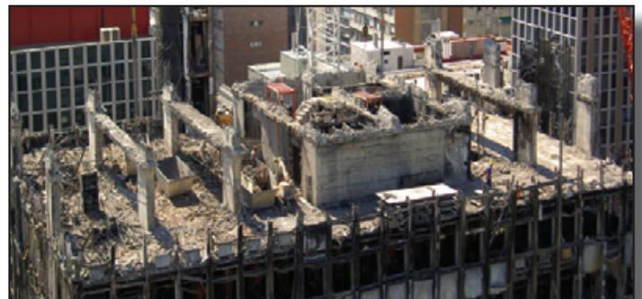
Figura 4: Estructura central de hormigón y perimetral metálica
