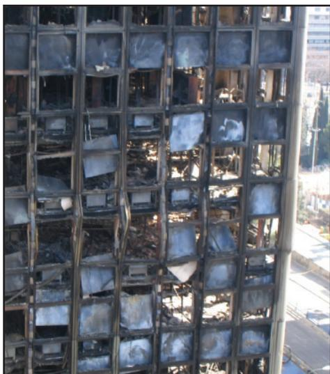
Figura 6: Estado de las placas de protección de fachada
