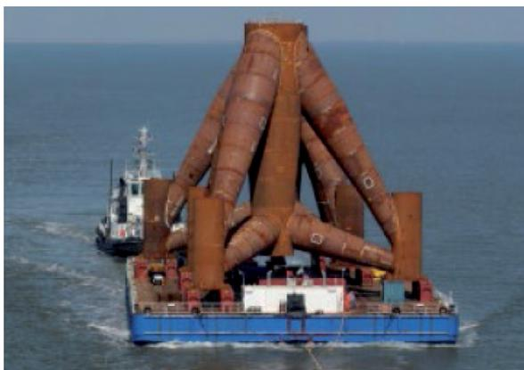
Estructura soporte de una torre off-shore hacia su emplazamiento
