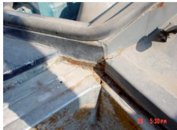
Figura 2: Fallo de análisis en el piso delantero de la puerta de ascenso
