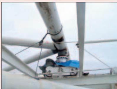
*Las 44 carretillas se desplazan sobre raíles y soportan el techo móvil del estadio.*
