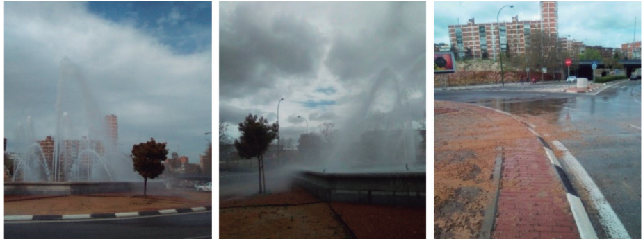
Fig. 2: Agua derramada fuera del vaso por la acción del viento y afección al entorno
