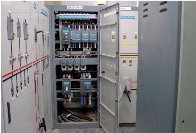
Fig. 6: Longitud sobrante de cable en el interior de un cuadro eléctrico
