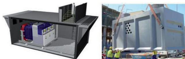
Figura 2: Centro de transformación subterráneo, vista del interior y exterior antes de enterrarlo
