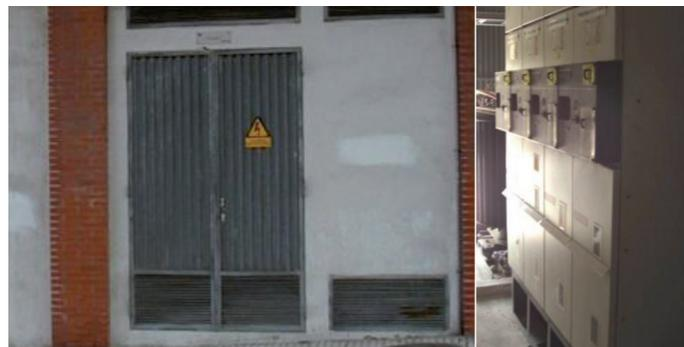
Figura 1: CT tipo interior de edificio, visto desde afuera y desde adentro
